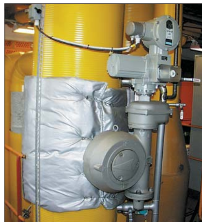
Ilustracja 10. Napęd SIPOS 5 Flash w węźle ciepłowniczym
