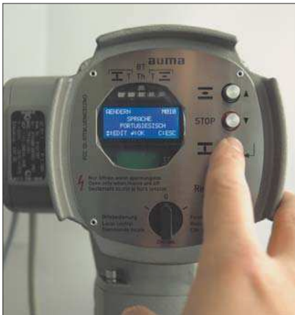
Ilustracja 2. Parametryzacja urządzenia za pomocą poleceń menu wybieranych na wyświetlaczu
