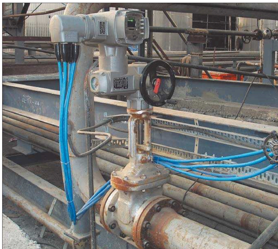
Ilustracja 1. Napędy elektryczne automatyzują pracę armatury przemysłowej wszelkiego rodzaju
