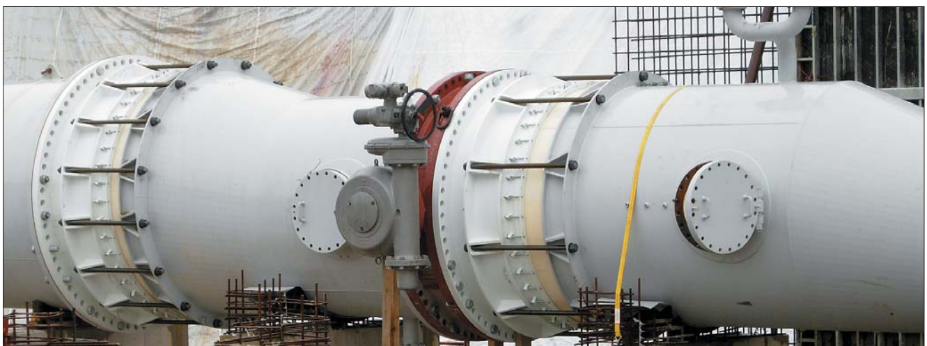
Ilustracja 1. Połączenie napędu i przekładni w instalacji filtrowania wody
