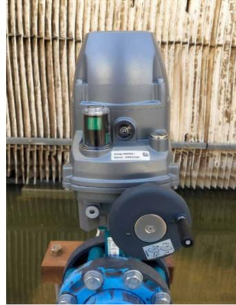
In der zentralen Kühlanlage in Palm Jumeirah ersetzen 196 kompakte, smarte PROFOX Stellantriebe alte, fehleranfällige pneumatische Antriebe. AUMA kümmerte sich um die gesamte Projektabwicklung.
