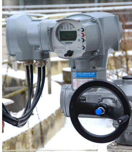
In der Kläranlage Marienheide werden rund 20 elektrische Stellantriebe von AUMA über einen redundanten Profinet-Ring angesteuert.
