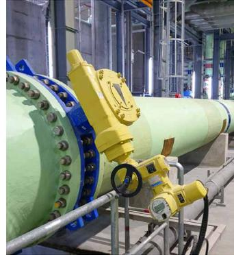
In der preisgekrönten Keppel Marina East Desalination Plant in Singapur sind 156 AUMA Drehantriebe SA und Schwenkantriebe SQ über alle Aufbereitungsstufen hinweg im Einsatz.
