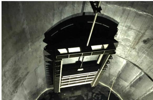
**AUMA Stellantriebe SA-UW für den dauerhaften Unterwassereinsatz sorgen für eine zuverlässige Betätigung von unterirdischen Notrollschützen – auch bei Überflutung.**
