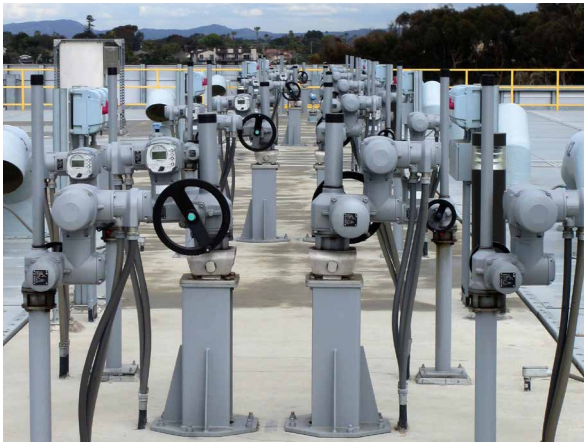
Keine Spur von Korrosion: AUMA Stellantriebe mit TÜV-zertifiziertem Korrosionsschutz halten der salzigen Meeresluft in Carlsbad stand.
