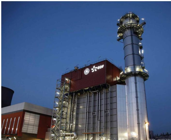
Das Gas- und Dampf-Kombikraftwerk (GuD) von EDF in Bouchain, Frankreich hält mit einer Effizienz von 62,22% den Weltrekord im Guinness-Buch der Rekorde. Kernstück des 605 MW Kraftwerks ist eine 9HA Gasturbine von General Electric (GE). Die hohe Effizienz wird unter anderem durch eine hohe digitale Integration von Feldgeräten wie Sensoren und Stellantrieben erreicht, die über Foundation Fieldbus in das Prozessleitsystem eingebunden sind.
